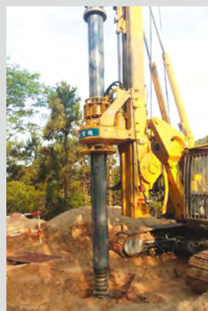
▲ 采用旋挖钻机进行架空线路基础开挖施工
