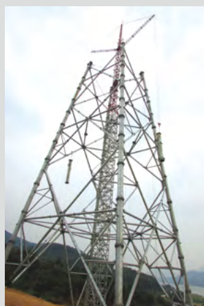
▲ 2X8t 集控式液压双摇臂抱杆起吊组塔施工
